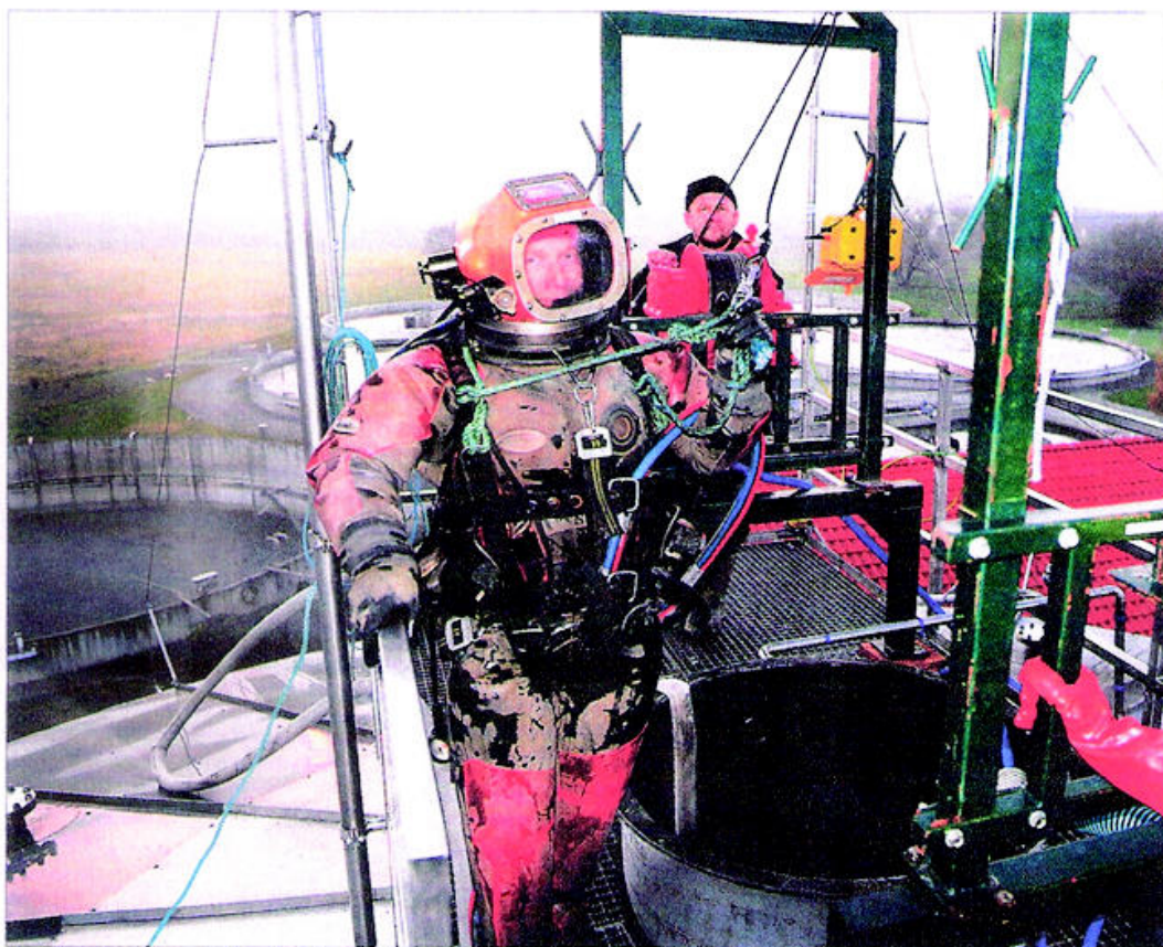
Berufstaucher Dietmar Torbahn bereitet sich auf den Einstieg in den zwölf Meter hohen Faulturm der Hillersleber Kläranlage vor. Foto: privat
